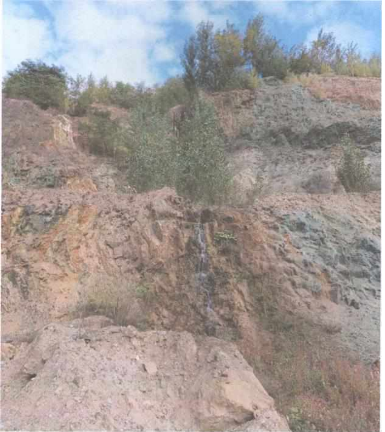
Мал.3.7 - Фото водопрояву № 3в
