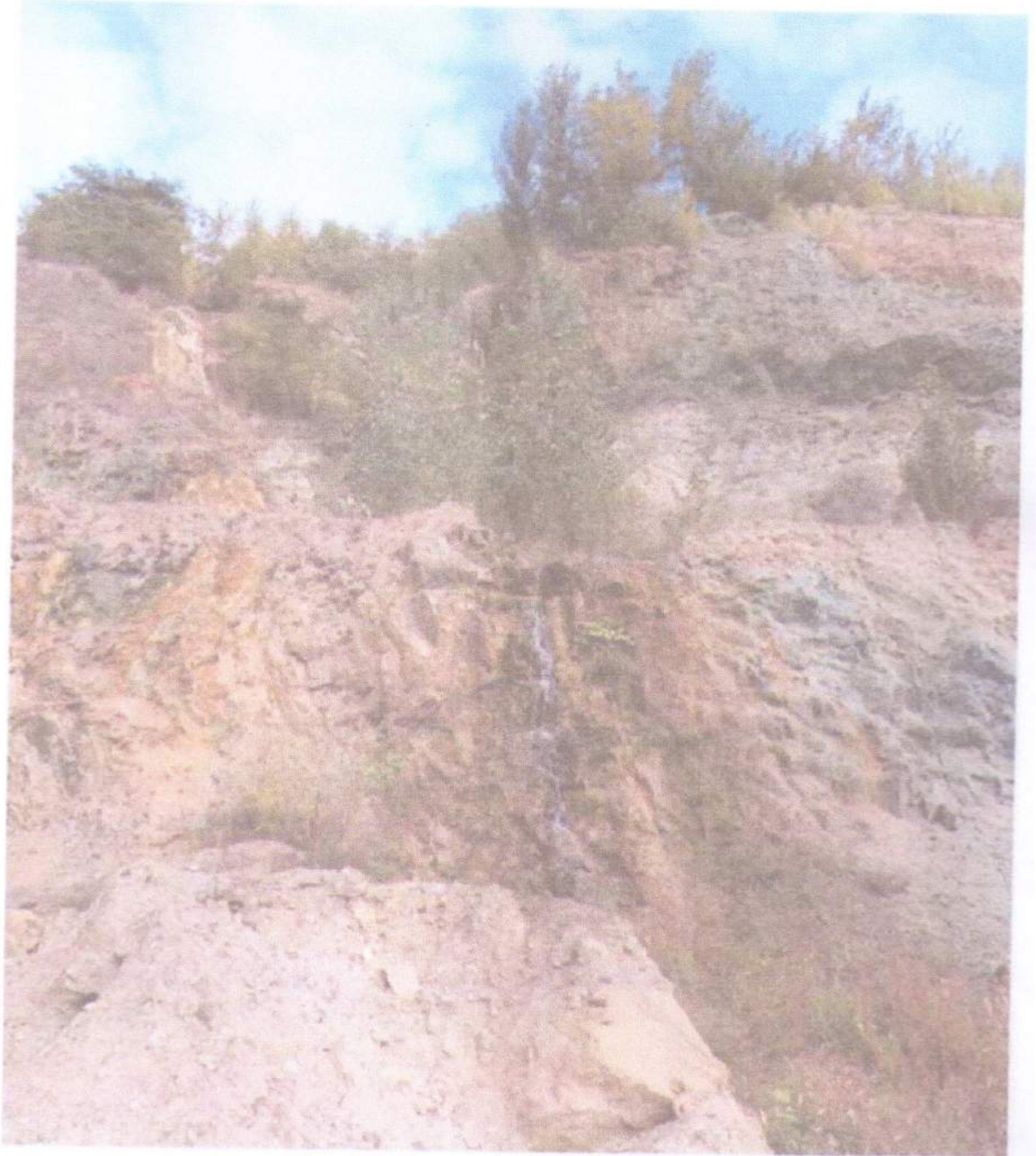
Мал. 3.12 Фото водопрояву № 3в
